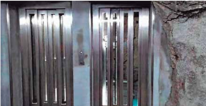
La puerta de piso Wittur instalada en la llegada de los ascensores.
